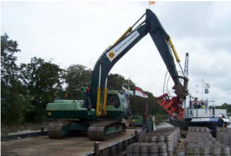
Betonklem aan kraan
